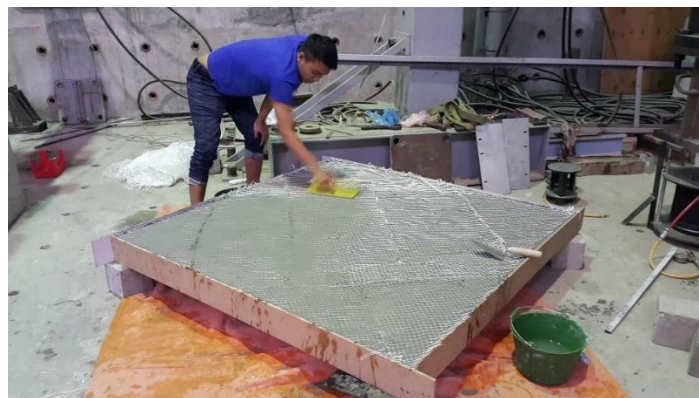
Hình 3. Quá trình gia cường bản BTCT bằng TRC
