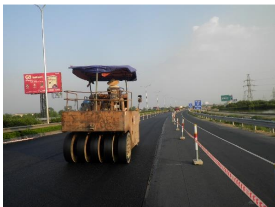
Hình 8. Thi công BTNRTN trên cao tốc Pháp Vân - Cầu Giẽ
