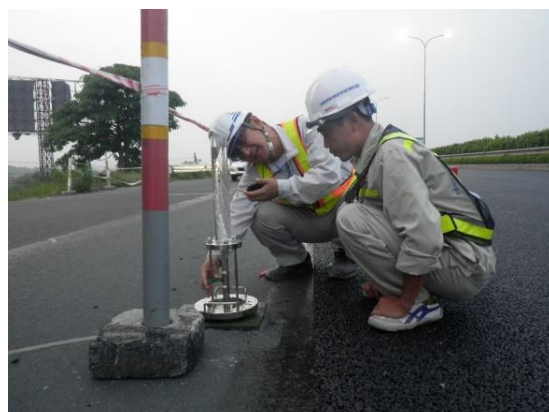
Hình 9. Thí nghiệm thấm nước hiện trường
